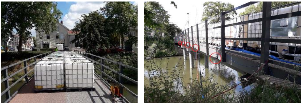
Figuur 9: Positionering van de 32 IBC watervaten op en de vijf prisma's langs de rand van het brugdek op de stroomopwaartse Candabrug te Brugge
